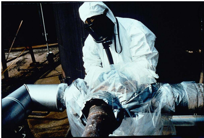
Abb. 12.12 Handschuhbeutel zur kontrollierten Entfernung von Asbestverkleidung (Diese Fotos wurden freundlicherweise von INRS zur Verfügung gestellt; Copyright INRS).
