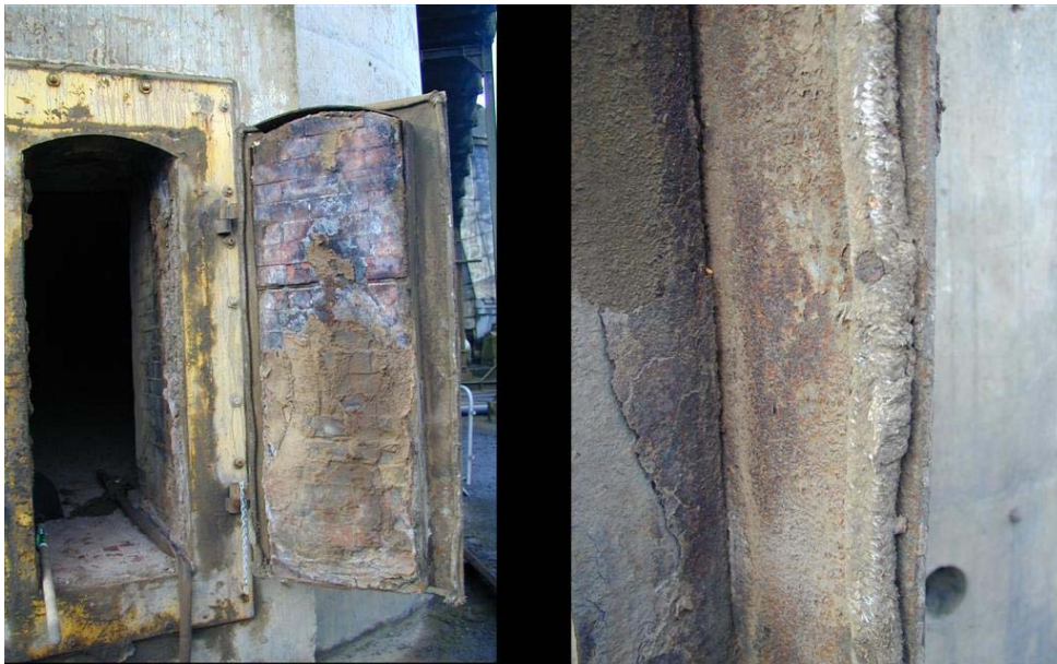
Abb. 4.12 Abdichtung einer Schornsteintür mit Asbestschnur. Rechts eine Nahaufnahme der Asbestschnur.
