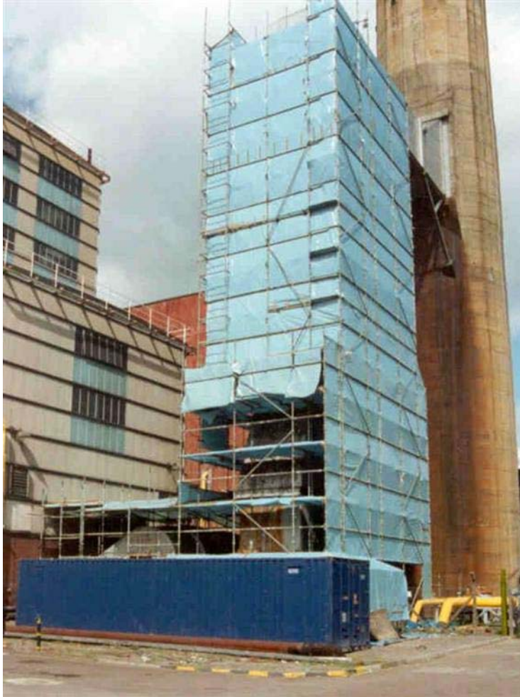
Abb. 12.3 Einhausung zum Entfernen der Isolierung eines Rauchgasrohrzugs.
