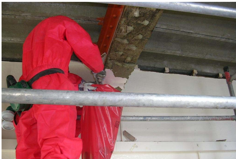
Abb. 12.11 Absacken des Asbestabfalls direkt an der Entfernungsstelle, um zu verhindern, dass sich Asbest verbreitet und um die Asbestexposition auf ein Mindestmaß zu reduzieren.
