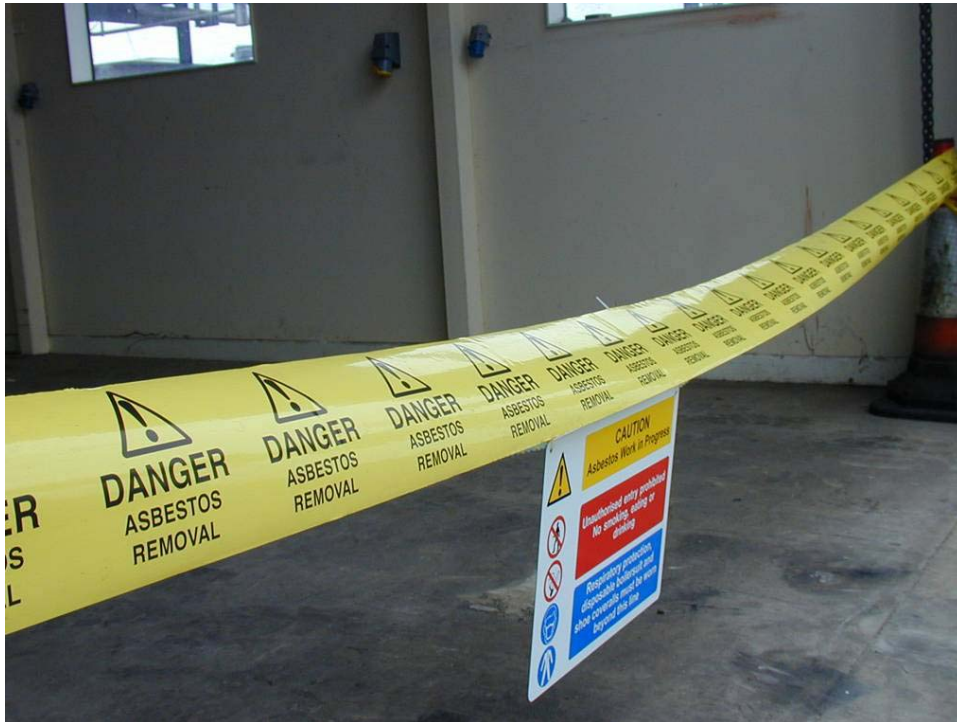
Abb. 11.1 Verwendung von Warnband (Aufschrift “GEFAHR Entfernung von Asbest”) und Schildern, um einen Bereich abzutrennen
