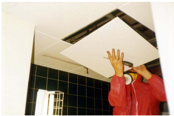
Abb. 12.13 Vorsichtiges Lösen einer Asbest-Deckenplatte. Diese Abbildung wurde von dem UK HSE zur Verfügung gestellt.
