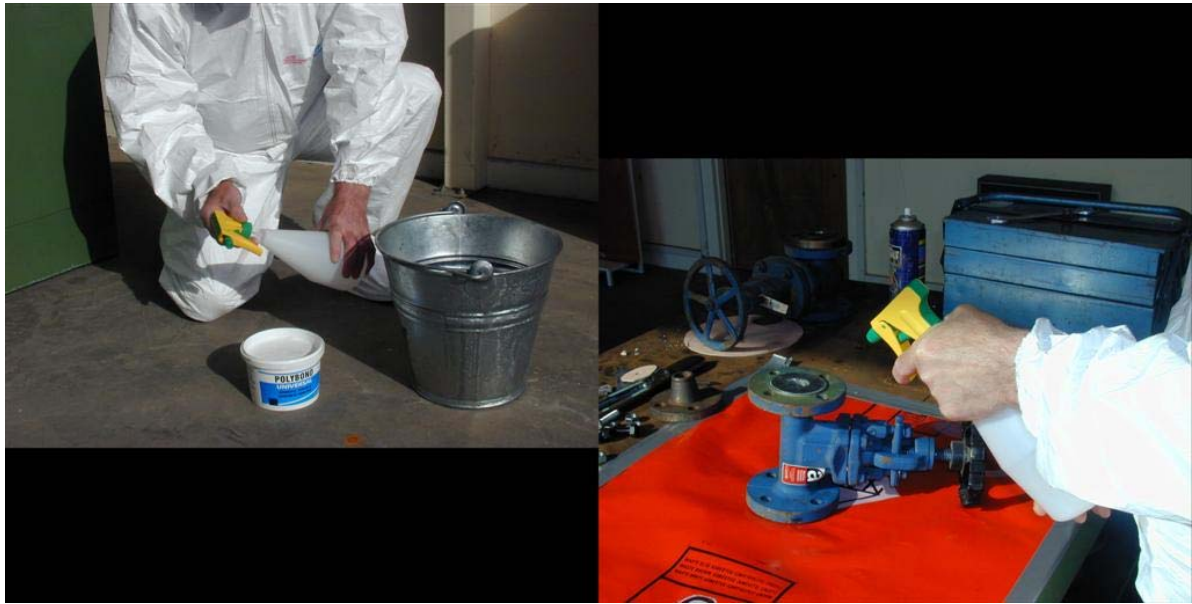
Abb. 11.4 Die Asbestdichtung auf einem Ventil wird angefeuchtet
