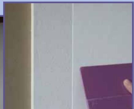
**HINWEIS:** Durch die Überklebung der gesamten Fläche mit Renoviervlies kann bei der Überspachtelung der Plattenstöße auf den Einsatz eines Armierungsgewebes verzichtet werden.
