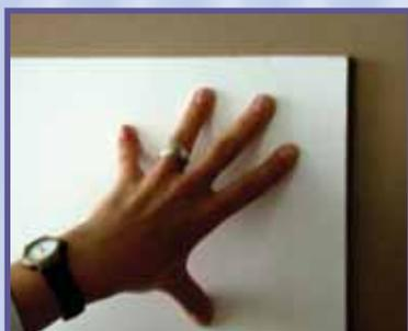
**Superwand DS<sup>®</sup>** auf der Wand ansetzen, lotgerecht ausrichten und fugenlos aneinander stoßen. Platten von unten nach oben anbringen und darauf achten, dass sie an Decke und Boden anschließen. **Superwand DS<sup>®</sup>** unter leichtem Druck mit der Rolle sorgfältig anpressen. Noch besser ist das Anklopfen mit einem sauberen Gummihammer und Hartholzbrett.
