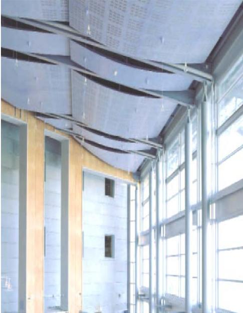
Rigiton steht für ein umfangreiches Sortiment an qualitativ hochwertigen und akustisch wirksamen Lochplatten aus dem umweltverträglichen Rohstoff Gips. Rigiton BIG 4AK wird zu fugenlosen Deckensystemen montiert und gestaltet so ein einheitliches und architektonisch elegantes Deckenbild. Durch ihre 4-fach abgeflachte Kante garantiert sie zudem eine sehr hohe Fugenfestigkeit und optisch perfekte Oberflächen.
