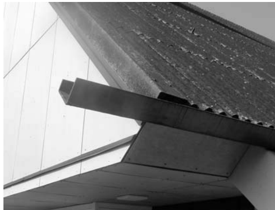
Asbestzement-Wellplatten, Foto IST
