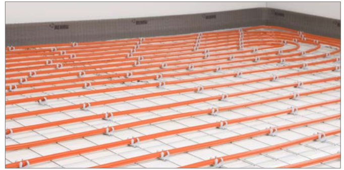
Abb. 4-118 System Rohrträgermatte mit Drehclip quattro
