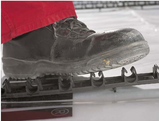
Abb. 4-134 RAUFIX-Schiene in Fußbodenaufbau drücken
