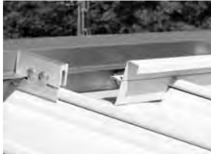
Abb.: Unterbauprofil mit Klemme u. Zahnleiste
