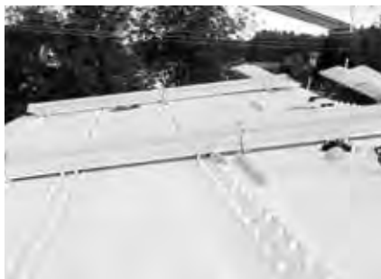
Abb.: Auskragung im Firstbereich
