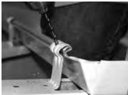
Abb.: Setzen des Fixpunkts mittels Edelstahl-Blindniete
