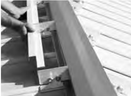
Abb.: Einschieben der Zahnleiste
