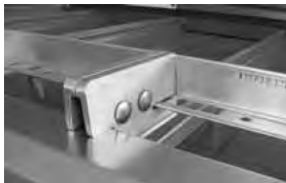
Abb.: Traufenklemme mit Schneefangwinkel
