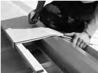
Abb.: Abdeckung mit Überschubblech
