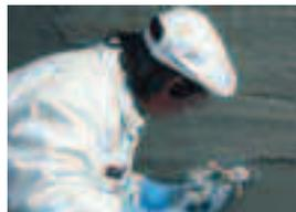
Bei stark saugenden und/oder unterschiedlich saugenden Untergründen muss zweischichtig nass in nass gearbeitet werden. Die Auftragsdicke der ersten Schicht sollte dabei ca. 2/3 der Gesamtputzdicke betragen.
