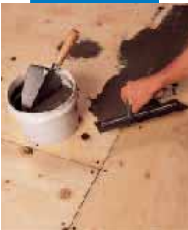
Spachtelung von Sperrholz mit Nivorapid + Latex Plus
