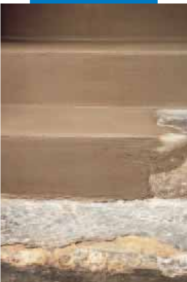
Instandsetzung einer Treppenkonstruktion mit Nivorapid
