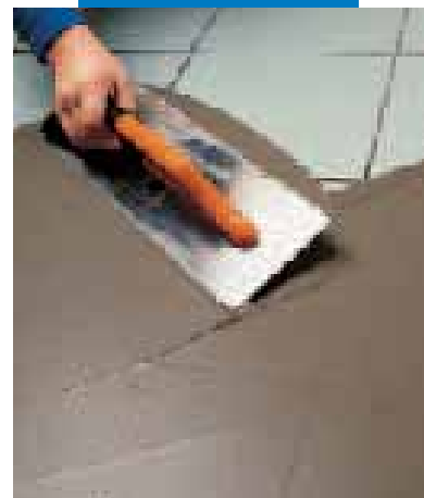
Spachtelung von gereinigten Altbelägen mit Nivorapid
