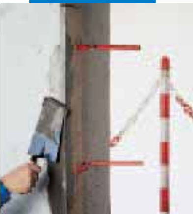
Kantenprofilierung mit Nivorapid
