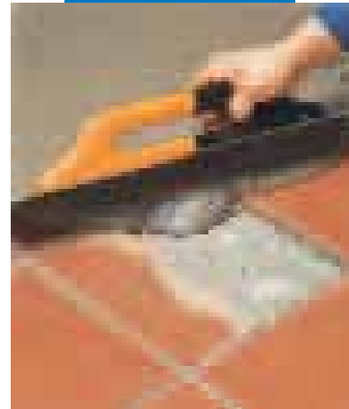
Ausgleich von Fehlstellen im Keramikbelag
