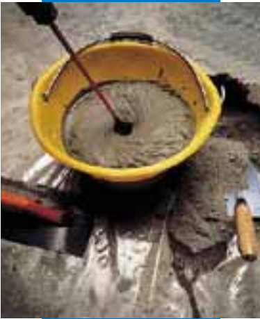
Anmischen von Nivorapid mittels Rührwerk
