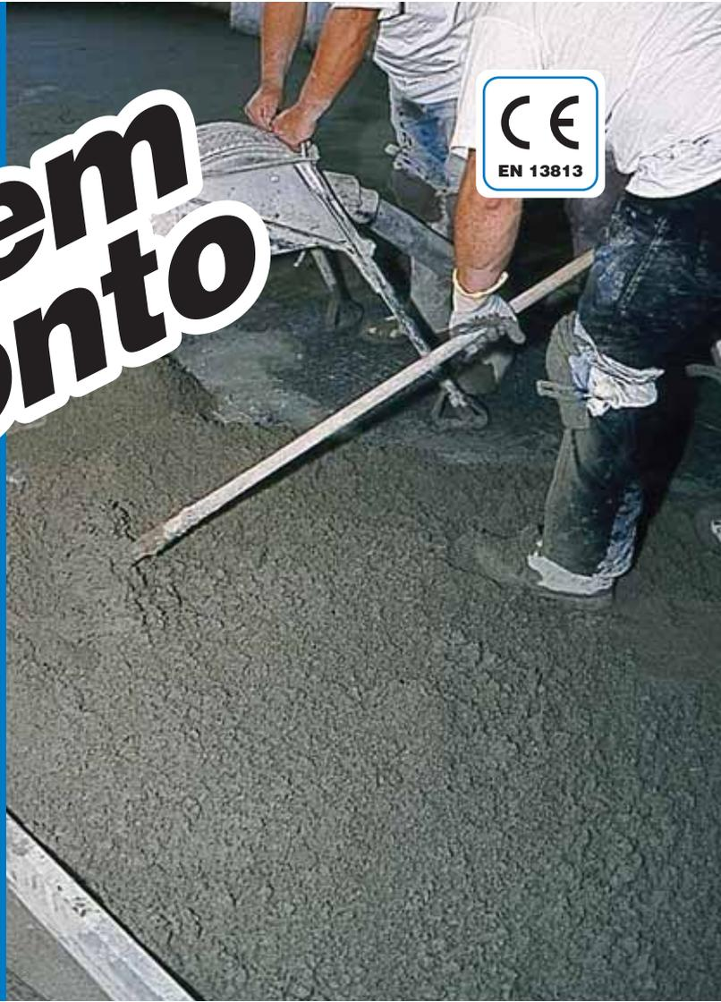
**Vorgemischter, gebrauchsfertiger Werkrockenmörtel mit schneller Festigkeits- und Feuchtigkeitsentwicklung sowie kontrolliertem Schwinden**
