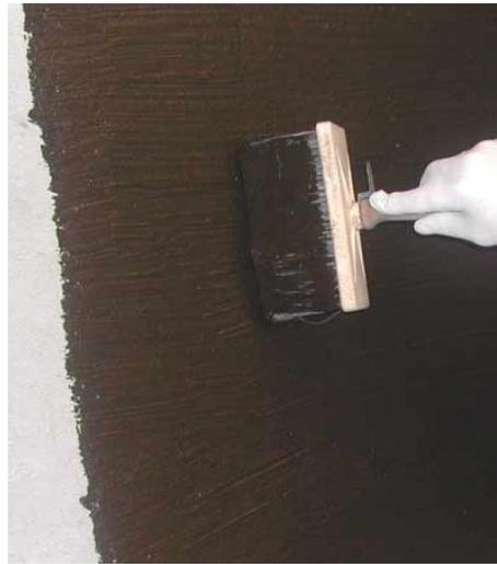
**Einkomponentige, lösmittelfreie, polystyrolgefüllte Bitumendickbeschichtung zur Abdichtung von erdberührten Bauteilen; Fußböden, Balkonen und Terrassen. Abdichtungsstoff gemäß DIN 18 195.**
