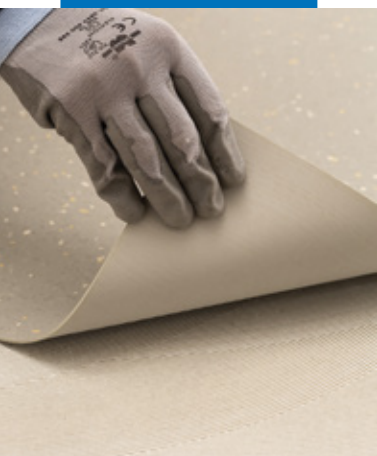
Verlegung von Kautschuk mit Ultrabond Eco V4 Evolution
