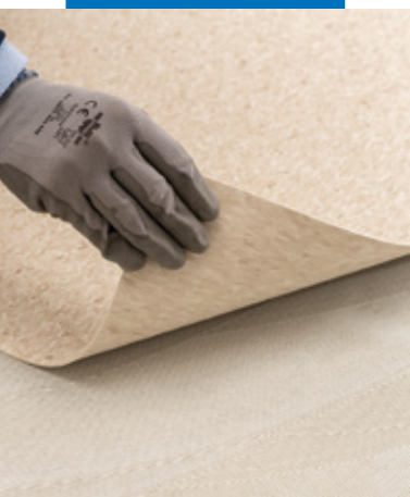
Verlegung von homogenen PVC-Belag mit Ultrabond Eco V4 Evolution
