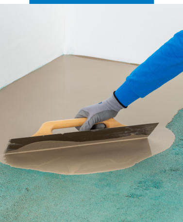
Auftrag einer selbstverlaufenden Mapei Spachtelmasse auf Mapeproof Primer
