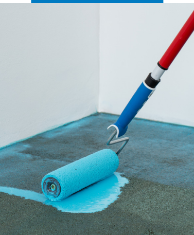
Zweiter Auftrag von Mapeproof Primer
