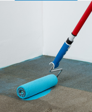
Erster Auftrag von Mapeproof Primer
