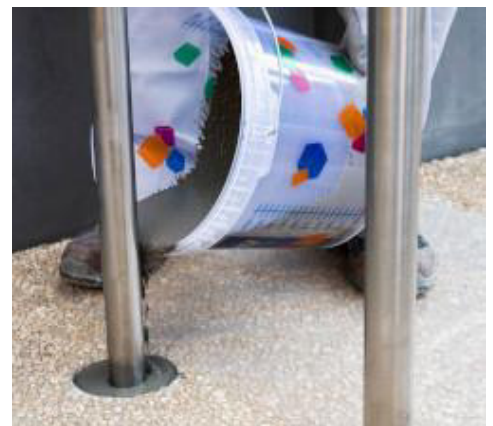
Verankerung von Stahlstützen
