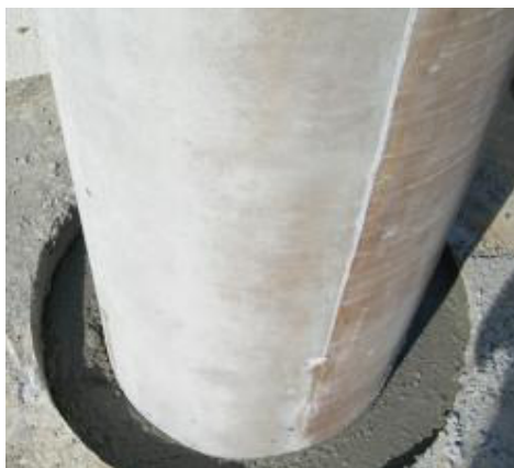
Verguss von Fertigsäulen
