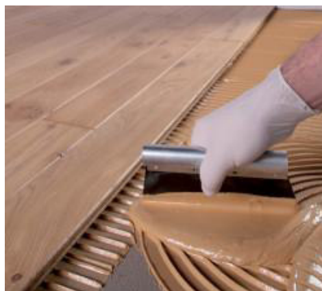
Auftragen von Ultrabond P990 1K
