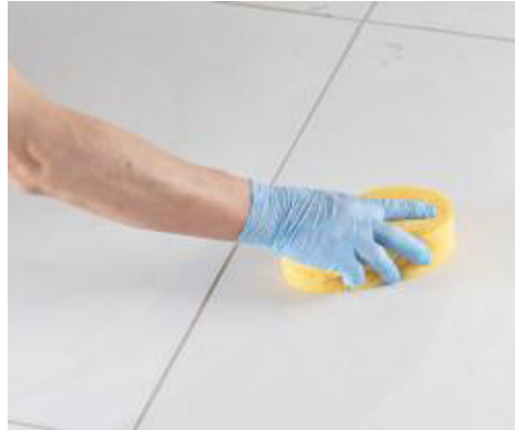
Endreinigung des Fugenmörtels mit einem Schwamm
