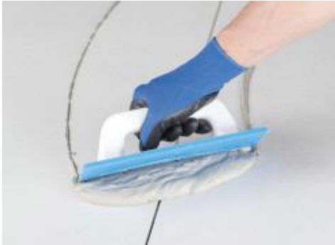
Verfugung eines Feinsteinzeugbodenbelags mit Marmoroptik mit Ultracolor Plus mittels Gummifugbrett
