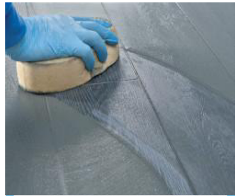
Endreinigung des Fugenmörtels mit einem Schwamm
