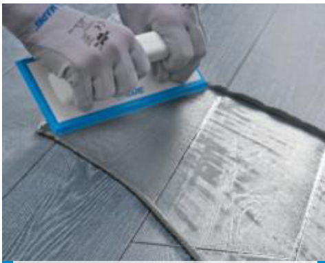
Verfugung eines Bodenbelags mit Holzoptik mit Ultracolor Plus mittels Gummifugbrett
