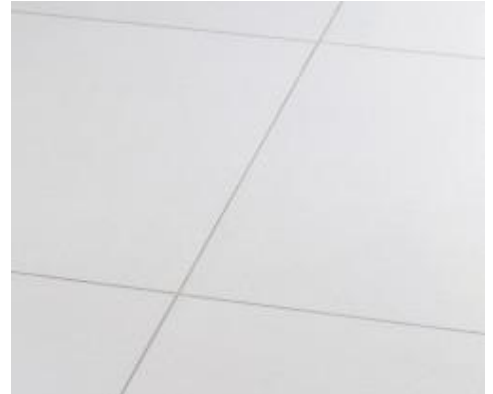
Bodenbelag verfugt mit Ultracolor Plus
