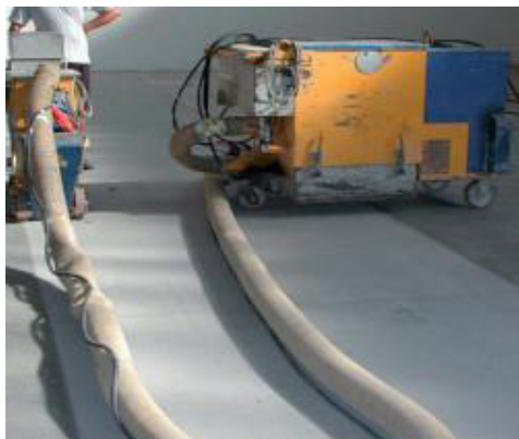
Untergrundvorbehandlung im Kugelstrahlverfahren
