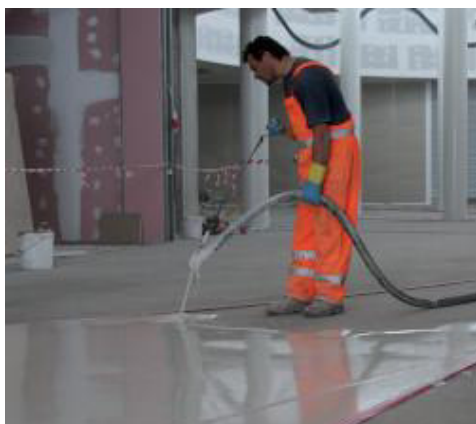
Applikation mit Mörtelpumpe
