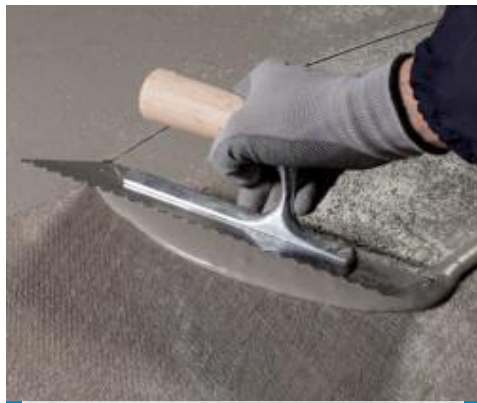
Auftrag der zweiten Schicht Mapelastic Turbo auf Mapetex Sel
