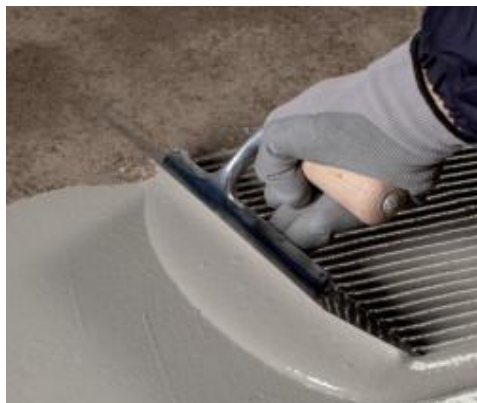
Auftragen der ersten Schicht von Mapelastic Turbo
