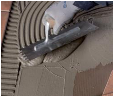
Verlegung der Fliesen mit Elastorapid
