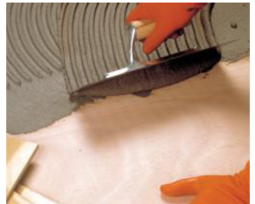
Verlegung von Feinsteinzeug mit Elastorapid
