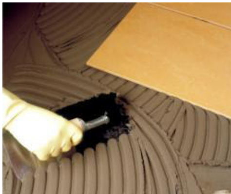
Verarbeiten von Elastorapid mittels Zahnkelle
