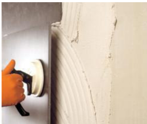
Ansetzen von grossformatigem Feinsteinzeug an einer Betonwand
