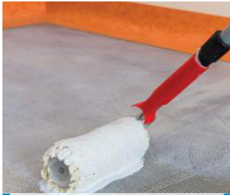
Auftragen von Eco Prim T Plus mit einer Rolle
