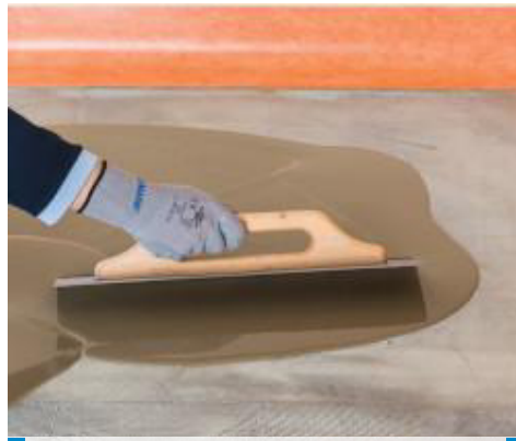
Verteilen von Ultraplan Fast Track mit einem Spachtel
