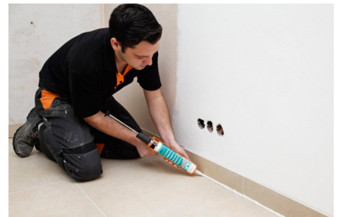
Elastisches Schließen von Boden-Wand-Fugen mit PCI Silcoform S ohne störende Geruchsbelästigungen während und nach der Verarbeitung.
