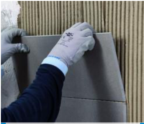
Verlegung von Feinsteinzeugplatten an der Wand
