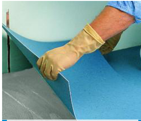
Verlegung von PVC-Platten mit Ultrabond Eco V4 SP Conductive
