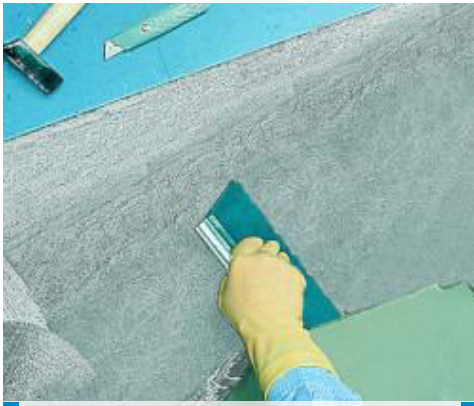
Verarbeitung von Ultrabond Eco V4 SP Conductive
