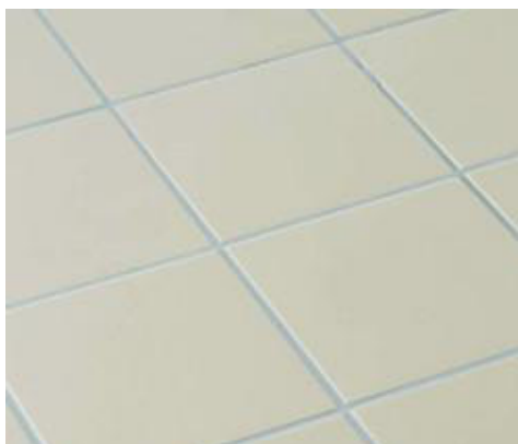
Endergebnis eines Bodens, der mit Kerapoxy CQ verfugt wurde
