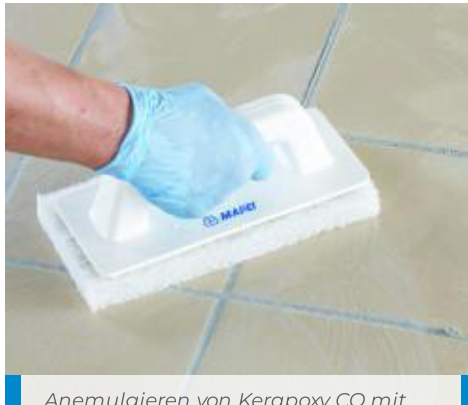
Anemulgieren von Kerapoxy CQ mit Wasser und einem Scotch-Brite®-Pad
