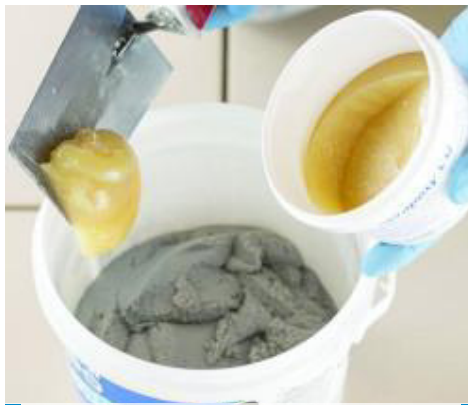
Den Härter (Komponente B) in das Gebinde der Komponente A geben
