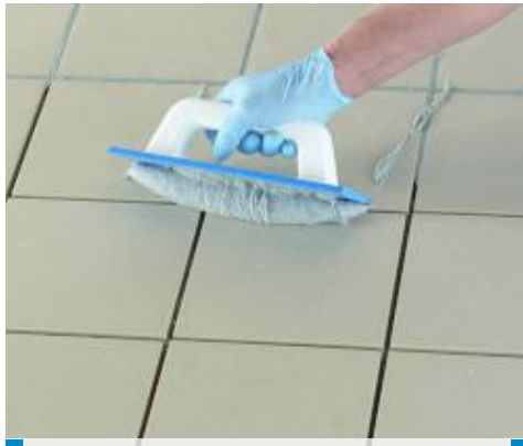
Auftragen von Kerapoxy CQ mit einem MAPEI-Fugenbrett
