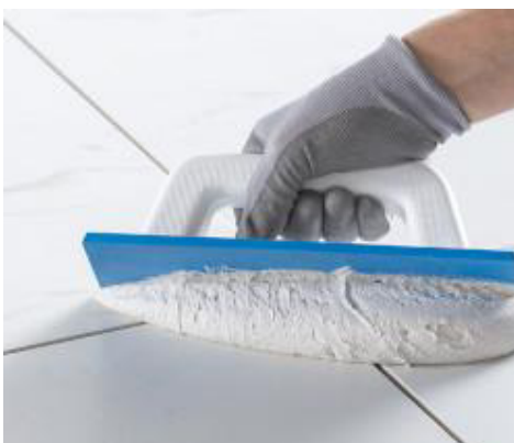
Kerapoxy Easy Design mit Mapei-Gummifugscheibe auftragen
