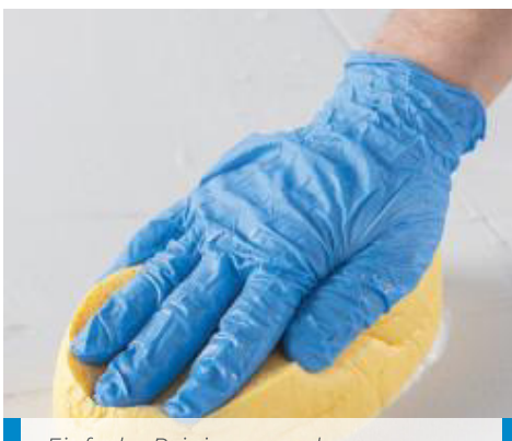
Einfache Reinigung und Nachbearbeitung mit einem Zelloswamm
