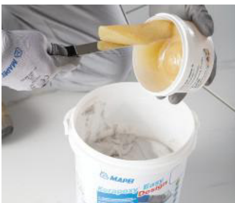
Zugabe des Härters (Komponente B) in das Gebinde der Komponente A
