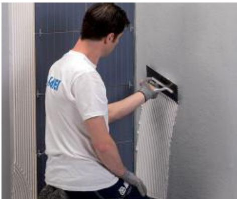
Ansetzen des Belags mit Keraflex Maxi S1
