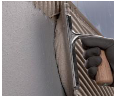
Ansetzen des Belags mit Ultramastic III
