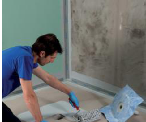
Einbau eines Bodenablaufs mit Mapegum WPS
