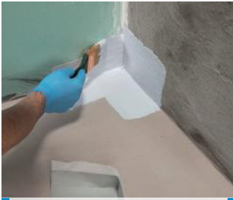
Einbau einer Mapeband PE 120 Innenecke mit Mapegum WPS
