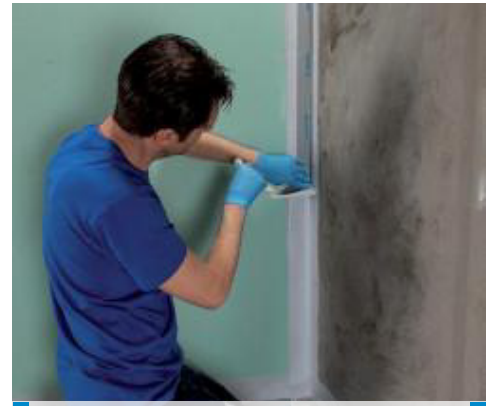
Einbau Mapeband PE 120 mit Mapegum WPS
