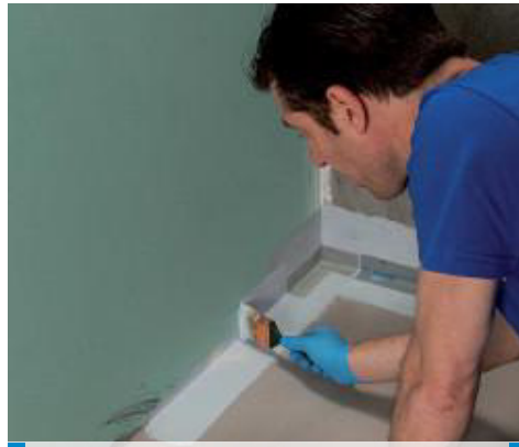
Einbau Mapeband PE 120 mit Mapegum WPS
