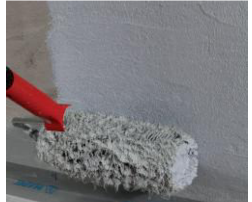
Auftragen von Mapegum WPS mit einer Rolle
