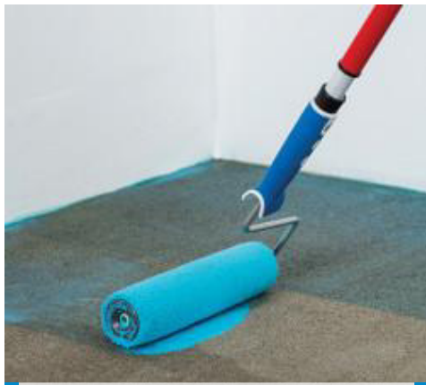
Erster Auftrag von Mapeproof Primer
