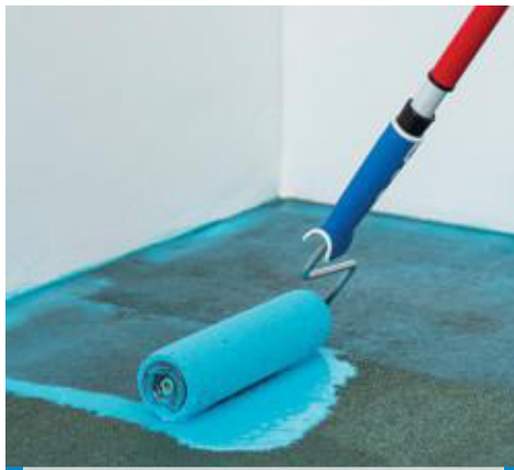
Zweiter Auftrag von Mapeproof Primer
