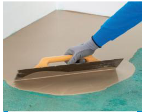
Auftrag einer selbstverlaufenden Mapei Spachtelmasse auf Mapeproof Primer
