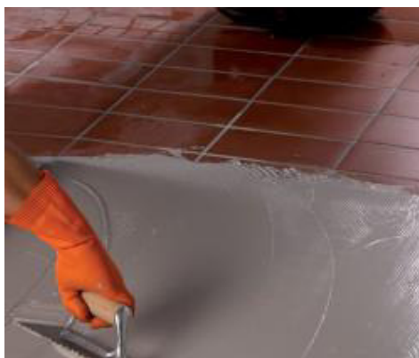
Auftragen einer zweiten Schicht von Monolastic auf Mapenet 150 .
