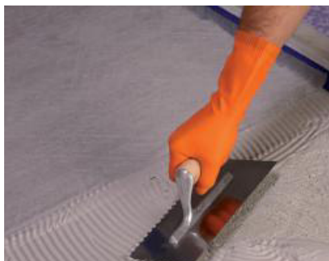
Auftragen einer ersten Schicht von Monolastic , verschweisst mit Mapetex Sel N , auf einem neuen Estrich.
