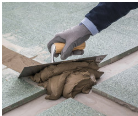
Füllen von Aussparungen mit Planipatch Xtra
