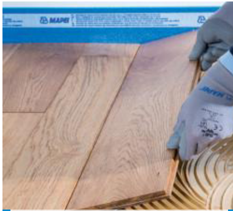
Verlegung von Parkett
