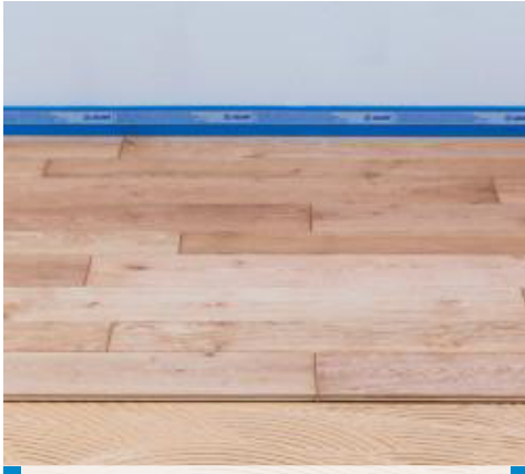
Verlegung von Parkett
