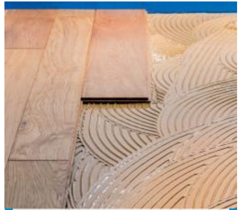
Verlegung von Parkett
