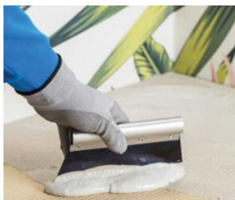
Auftrag von Ultrabond Eco TX3 auf der Dämmunterlage
