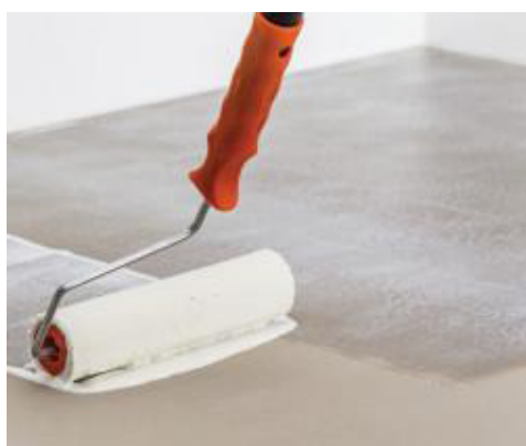
Auftrag von Ultrabond Eco Tack TX+ zur Fixierung einer Dämmunterlage
