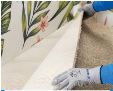
Verlegung eines Teppichbodens auf der Dämmunterlage (Kontaktklebung)
