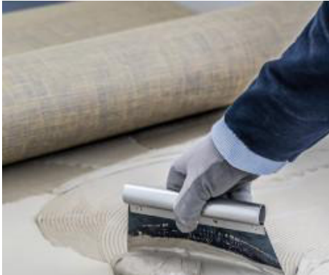
Auftrag von Ultrabond Eco TX3 zur Verlegung von Linoleum
