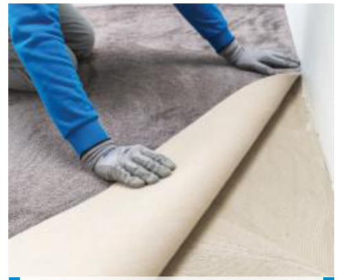
Verlegung eines Teppichbodens mit Action-Bac®
