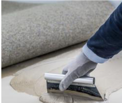
Auftrag von Ultrabond Eco TX3 zur Verlegung von Nadelvlies
