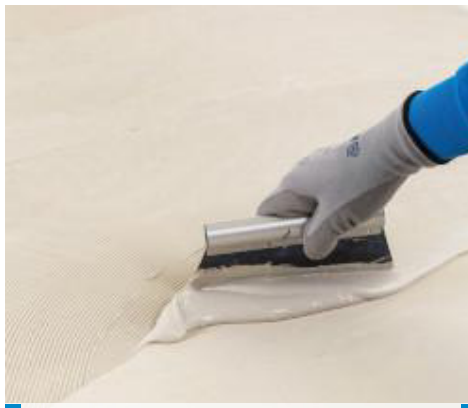
Auftrag von Ultrabond Eco TX3 auf einer Spachtelmasse (Direktklebung)
