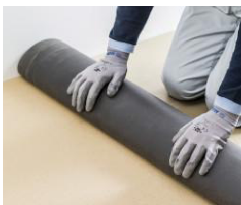
Verlegung einer Dämmunterlage
