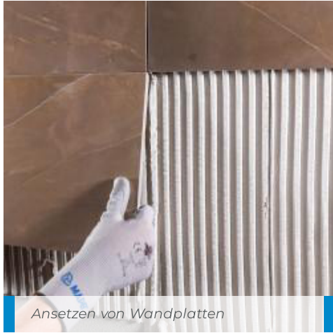
Verlegung von Keramik in Holzoptik auf einen mit Mapelastic abgedichteten Untergrund
