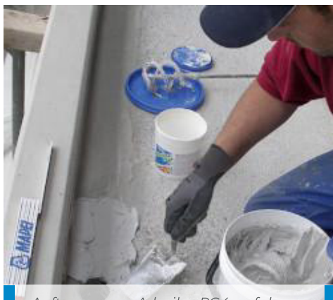
Auftragen von Adesilex PG4 auf den Untergrund
