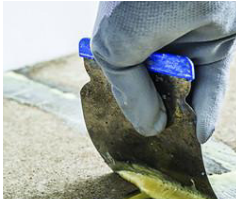
Gleichmäßiges Verteilen des Produktes zum Füllen des Risses
