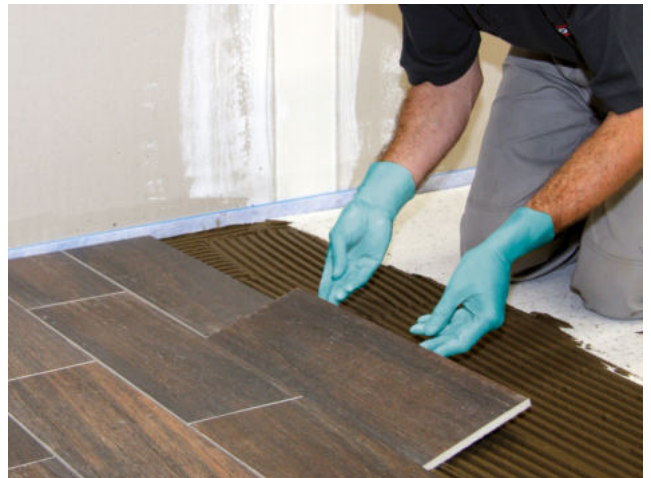
Verlegen der keramischen Fliesen in das vorbereitete frische Mörtelbett.
