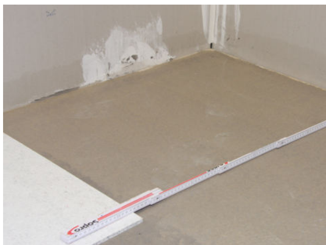
Die genaue Vermessung des Raumes vor der Verlegung ist empfehlenswert.
