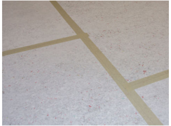
Zur Vermeidung von Mörtelbrücken (Körperschallbrücken) werden die Stöße der Platten mit Klebeband überklebt.
