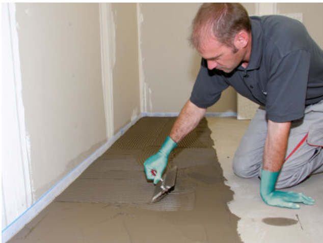
Nach Trocknung der Spachtelmasse wird auf den planebenen Untergrund z. B. Sopro's No. 1 Flexkleber aufgetragen.
