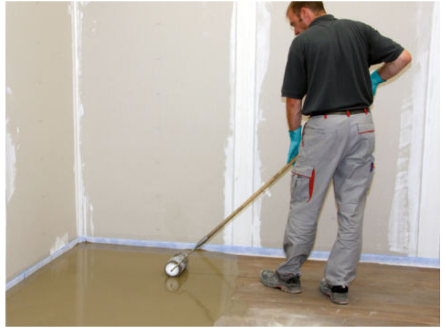
Mit einer Stachelwalze wird die aufgebraute Spachtelmasse verteilt und verdichtet, um eine planebene Oberfläche zu erhalten.
