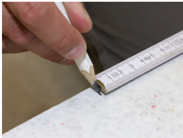
Anriss zum maßgenauen Schneiden einer Sopro FliesenDämmPlatte.
