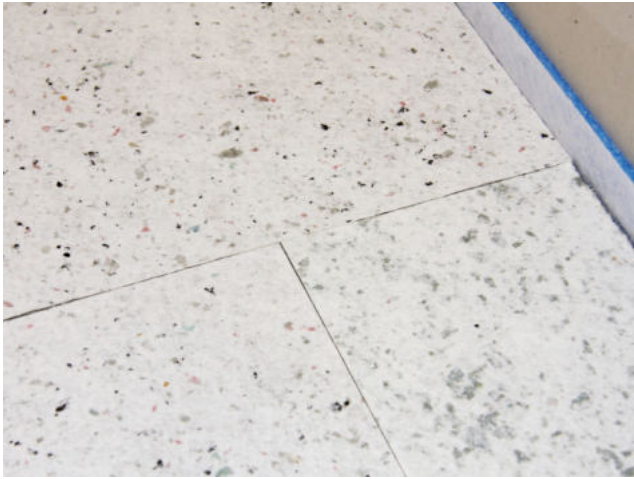
Plattenstöße nebeneinanderliegender Reihen werden versetzt verlegt.
