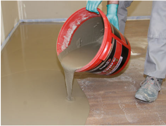
Der selbstnivellierende, faserarmierte und flexible Sopro FaserFließSpachtel wird im direkten Kontakt zum Holzdielenboden aufgebracht.
