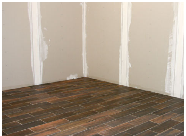
Entkoppelter, frisch verlegter und verfugter keramischer Belag auf einem Holzuntergrund.
