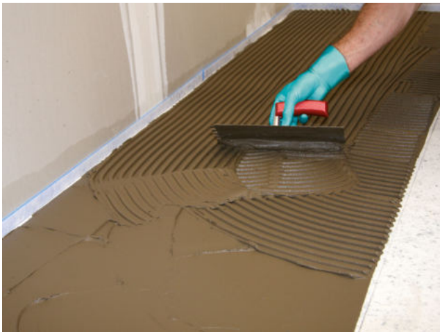
Auftrag von z. B. Sopro's No. 1 Flexkleber mit einer Zahnkelle auf die Sopro FliesenDämmPlatte für die anschließende Verlegung des keramischen Belages.
