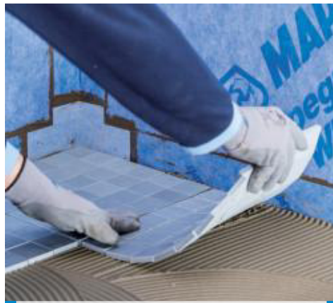
Verlegung von keramischen Fliesen
