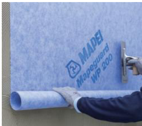
Verlegung von Mapeguard WP 200
