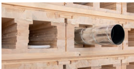
Werkseitige Installation von Lüftungsrohren (Wickelfalz) in BV-Elemente
