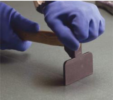
Anreiben des Belages über der Fuge
