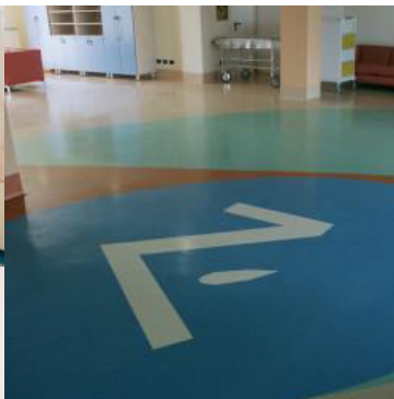
Anwendungsbeispiel für die Verlegung von PVC Platten im St. Josef Krankenhaus – Deutschland
