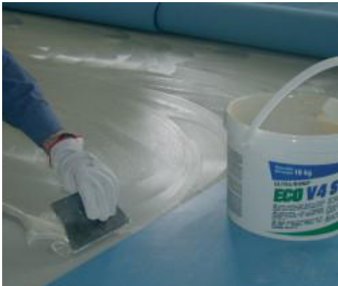
Auftragen von Ultrabond Eco V4SP im San Martino Altersheim – Italien
