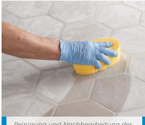
Reinigung und Nachbearbeitung der Fuge mit einem harten Zelluloseschwamm
