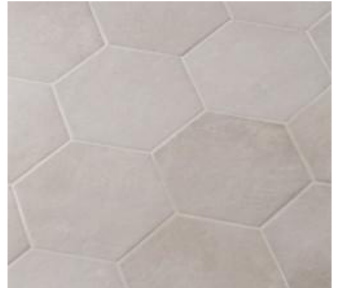
Boden mit Keracolor FF verfugt
