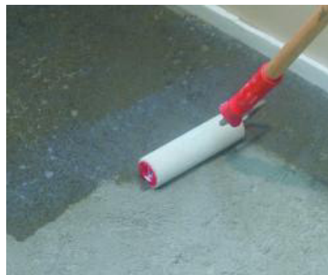
Auftragen von Primer G mit der Rolle
