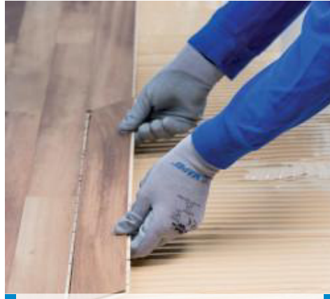
Verlegung des Parketts
