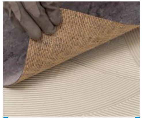
Verlegung von Linoleum mit Ultrabond Eco V4 Evolution
