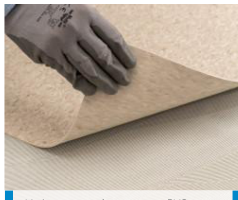
Verlegung von homogenen PVC-Belag mit Ultrabond Eco V4 Evolution
