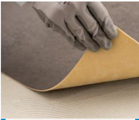
Verlegung von PU-Belag mit Ultrabond Eco V4 Evolution
