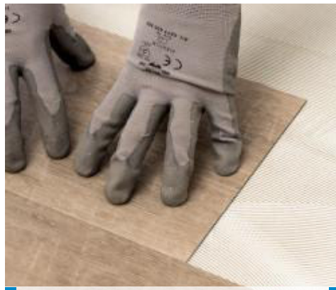
Verlegung von LVT mit Ultrabond Eco V4 Evolution
