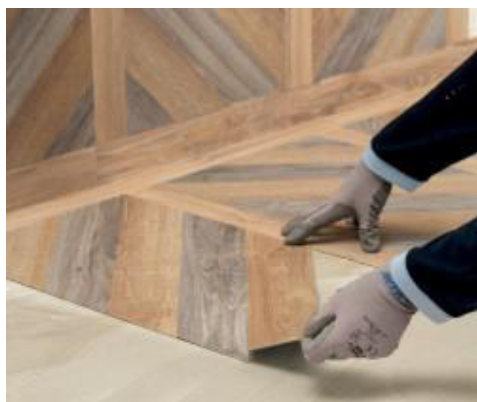
Verlegung von modularem LVT-Belag mit Ultrabond Eco V4 Evolution
