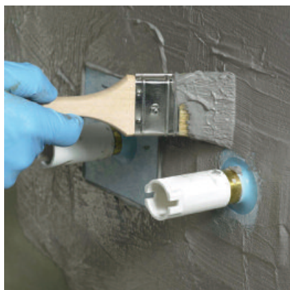
Die Dichtmanschetten PCI Pecitape 10 x 10 ordnungsgemäß einbetten.
