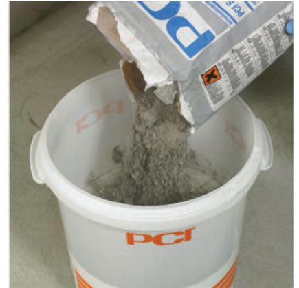
PCI Seccoral 2K Rapid Pulver dazugeben.
