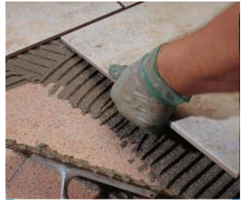
Verlegung von Feinsteinzeug mit Keraflex grau
