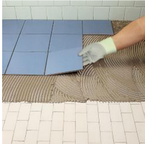
Verlegung von poliertem Marmor mit Keraflex weiss
