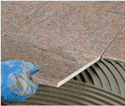
Verlegung von Steinzeug in Außenbereich mit Keraflex grau
