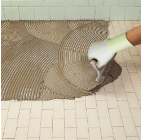
Verlegung von Steinzeug in Außenbereich mit Keraflex grau
