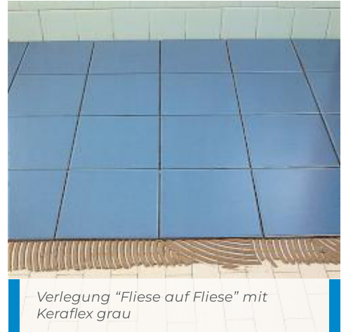
Verlegung von Feinsteinzeug mit Keraflex grau
