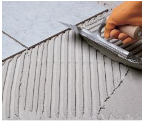
Verlegung von poliertem Marmor mit Keraflex weiss
