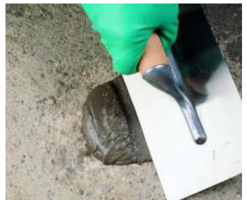
Ausgleich von Ebenheitstoleranzen in einer Betonflächen
