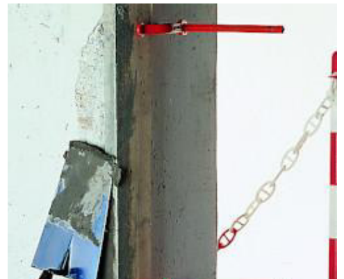
Kantenreprofilierung mit Nivorapid
