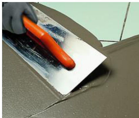
Spachtelung von gereinigten Altbelägen mit Nivorapid
