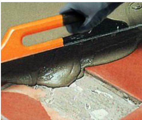
Ausgleich von Fehlstellen im Keramikbelag
