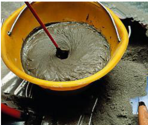
Anmischen von Nivorapid mittels Rührwerk
