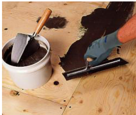
Spachtelung von Sperrholz mit Nivorapid + Latex Plus
