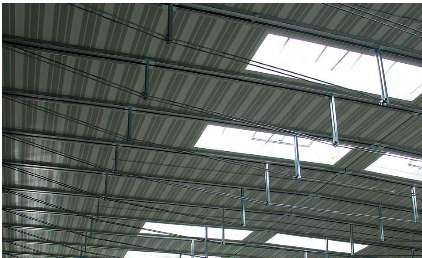
Untersicht: Akustikausführung mit perforierten Kassetten
