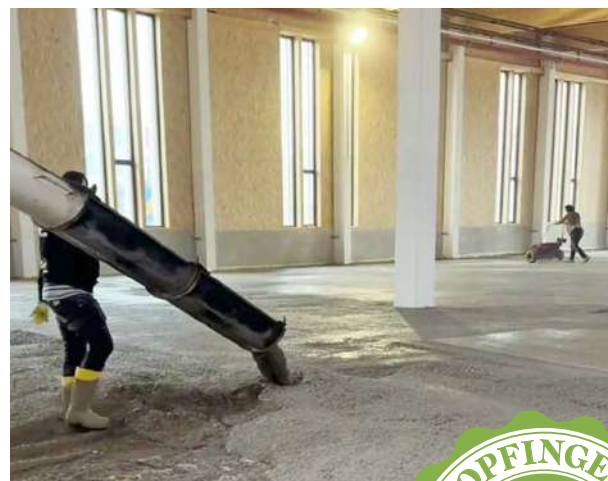
Innovation: ÖKOBETON-K als Hallenboden
